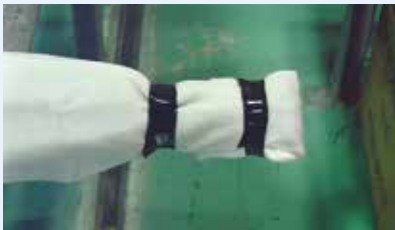
4 パッカー設置後 仮止め (先端部)
