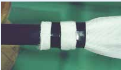
5 パッカー設置後 仮止め (孔口側)
