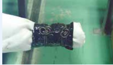
6 番線により固定 (先端部)
