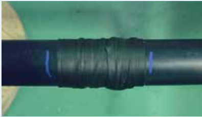
2 孔口側スパン シールテープ 取付
